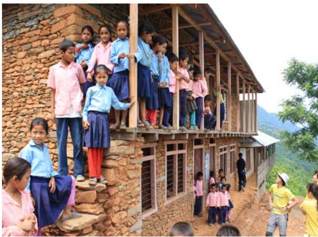
接近完工的校舍擴建工程 (相片由 Volunteer Space 提供 2010 年 5 月尾)
